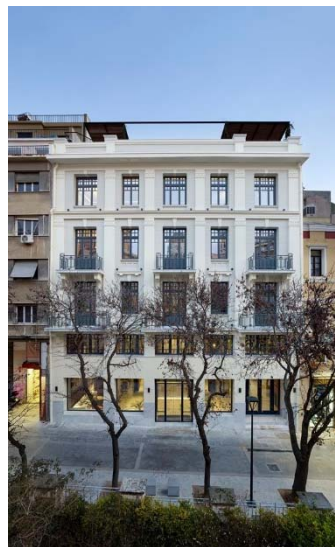
Σχήμα 3.1 Πρόσωση κτιρίου Prodea
