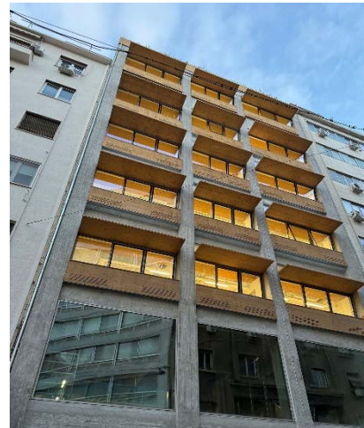
Σχήμα 3.5 Πρόσοψη κτιρίου ΔΟΛ
